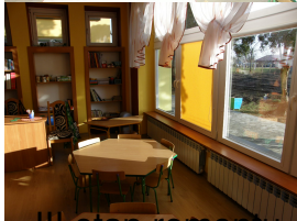
III etap remontu
