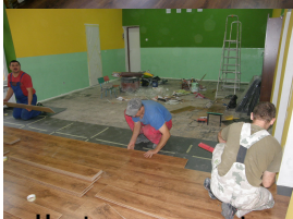
II etap remontu
